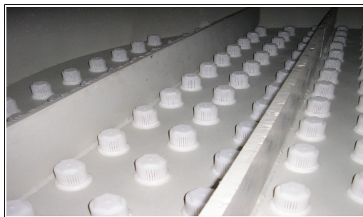
Zdjęcie 1. Wzmocnienie dna drenażowego w filtrach ciśnieniowych z płaskim dnem grzybkowym
