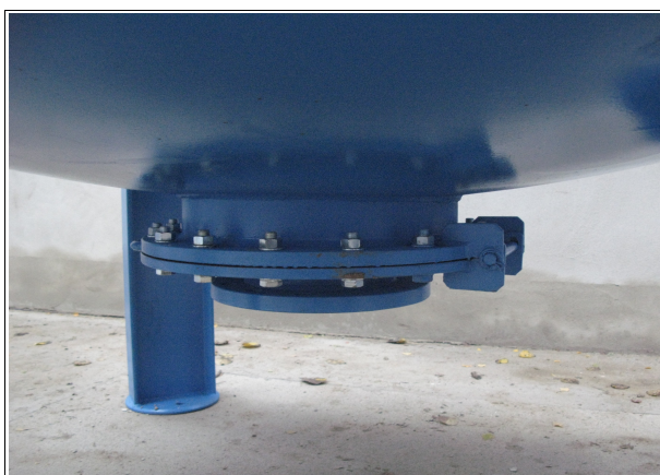
Zdjęcie 2. Winda i zawiasy umożliwiające łatwą obsługę filtra
